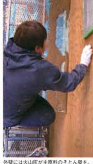
外壁には火山灰が主原料のそとん壁を。ムラなく完璧に仕上げるにはかなりの技が必要
