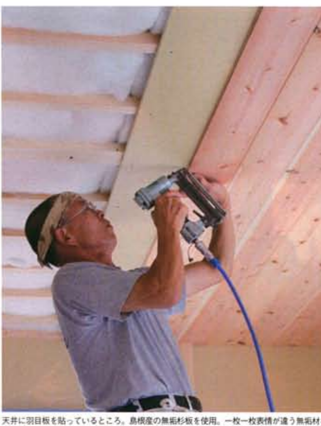
天井に羽目板を貼っているところ。鳥根産の無垢杉板を使用。一枚一枚表情が違う無垢材なので、正確に貼ることはもちろん、見上げたときのデザインを考え、板の配列を入れ替える
